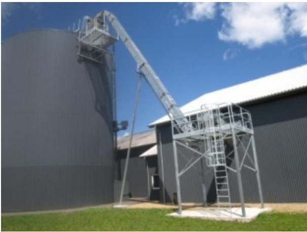
AUs biogasanlæg – Europas største forsøgsanlæg for biogas
